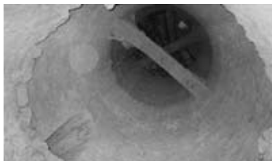
Pou de l'interior de la torre
